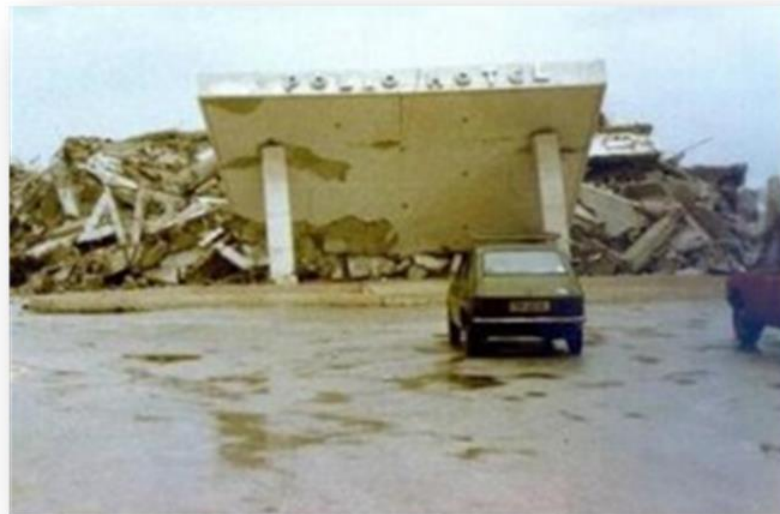
Σεισμός Αλκυονίδων, 24/2/1981. Κατάρρευση του ξενοδοχείου Απόλλων στο Λουτράκι -σεισμός των Αλκυονίδων (Πηγή: Αρχείο ΟΑΣΠ)
